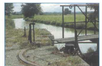
Une écluse ancienne
