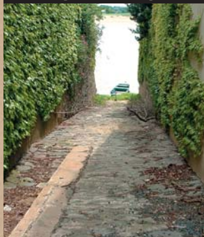
Ouvrage à témoigner
