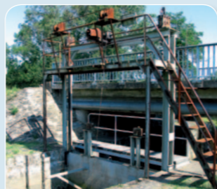
Vanne de la Chaussée
