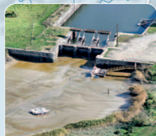
Vannage du Carnet
