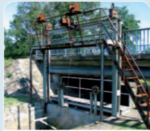
Vanne de la Chaussée
