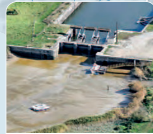
Vannage du Carnet
