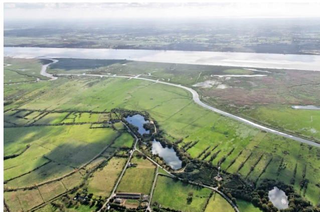
Canal de la Taillée, un des 4 exutoires de la Brière dans l'estuaire (Crédit photo : P GRAINDORGE – GERPHO)
