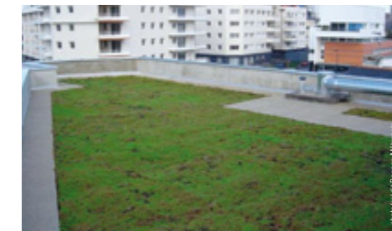
Toiture végétalisée ZAC Saint-Hélier Rennes Métropole
