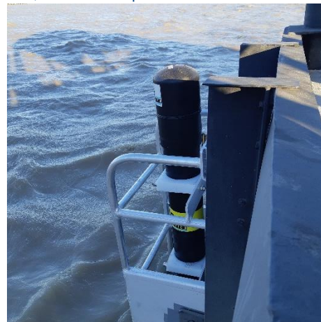
Sonde SAMBAT installée à Trentemoult en septembre 2019
